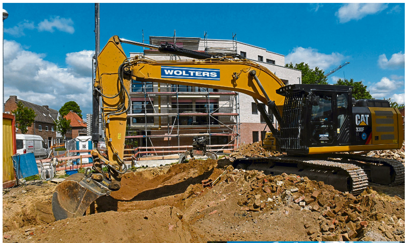
Der Bagger schaufelt das Loch für die künftige Tiefgarage, die unter der Tagespflegeeinrichtung entsteht. Foto: Günter Benning
